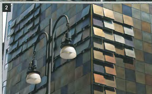
Fig. 1 – Il materiale utilizzato per produrre il rivestimento di facciata doveva essere tale da permettere la realizzazione di pannelli rigidi, consentire la microforatura con passo e profondità corrette per le prestazioni ottiche richieste, dare una resa cromatica non uniforme e molto simile a quelle del bronzo, dell'ottone, del rame e dell'oro.
